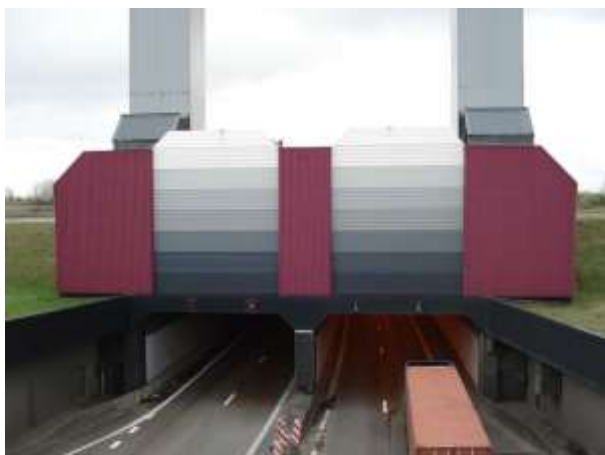
Tunnel payant à Anvers
